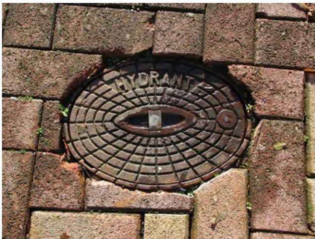
Abb. 7: Unterflurhydrant
