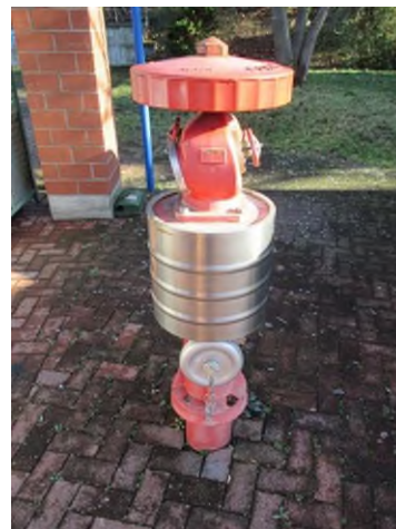
Abb. 8: Überflurhydrant
