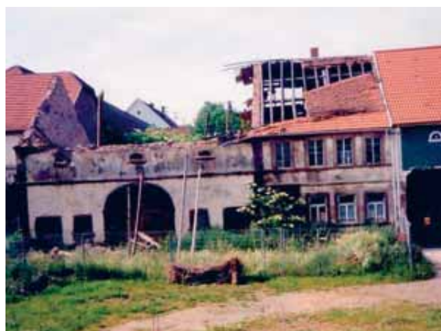
Man erkennt gut: rechts Wohnteil mit Eingang - links Wirtschaftstrakt mit Scheunentor.
