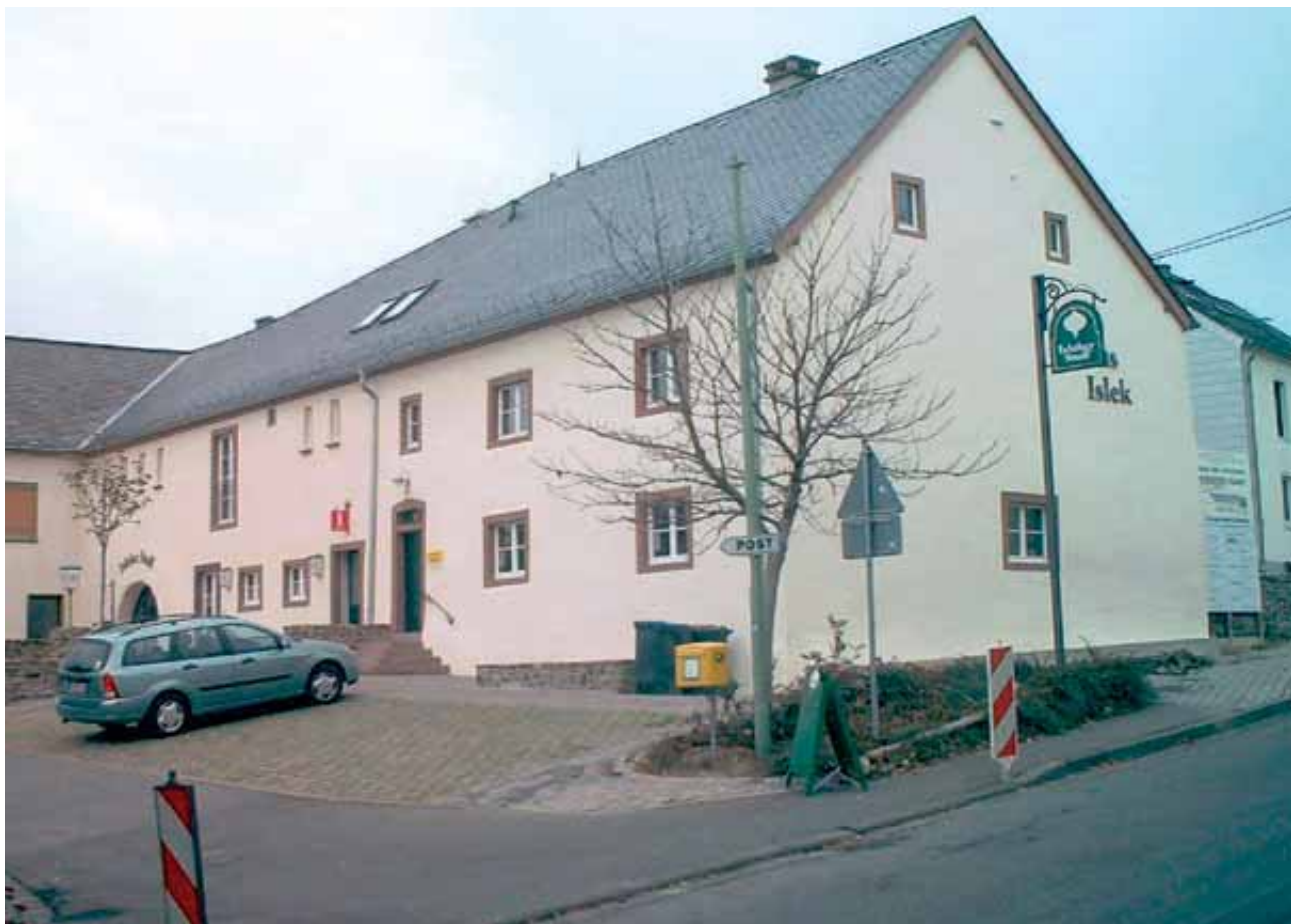
nach dem Umbau
