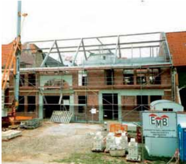
Konstruktion mit Stahlbindern
