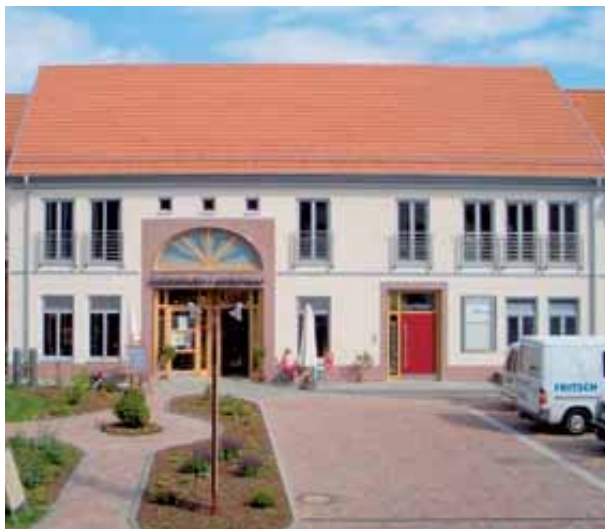
Vorderansicht nach Fertigstellung
