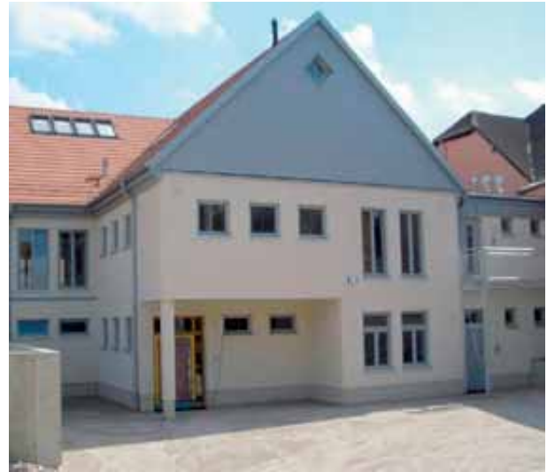
Rückansicht nach Fertigstellung
