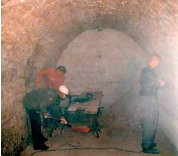
Gewölberaum- Jugendliche bei Abbrucharbeiten
