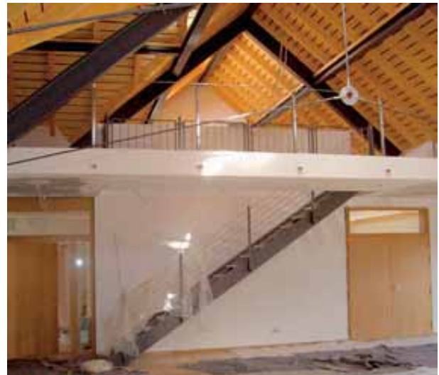
Gemeindesaal mit Galerie im Bau
