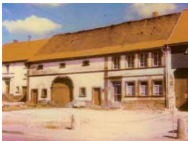
Hier ein Originalbild des Hauses aus besseren Zeiten.
