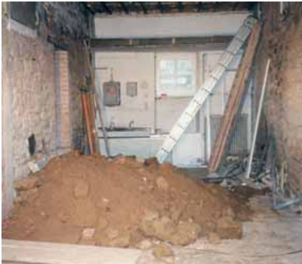
Gruppenraum 1 in der Bauphase
