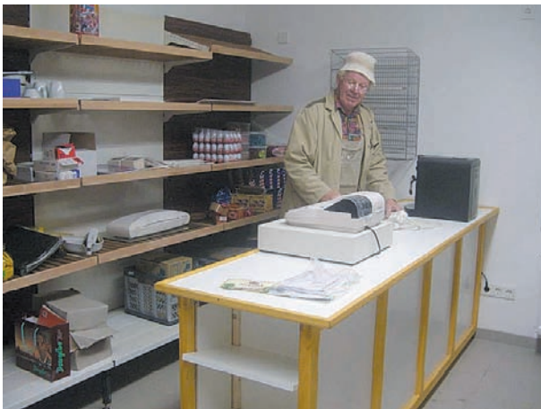
Einbau der Ladentheke
