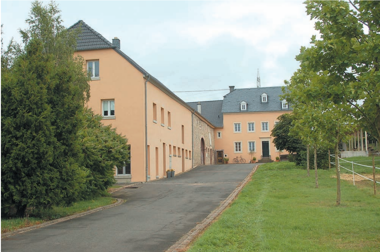
Große stattliche Hofanlagen wurden im Sinne der Dorferneuerung erhalten und saniert
